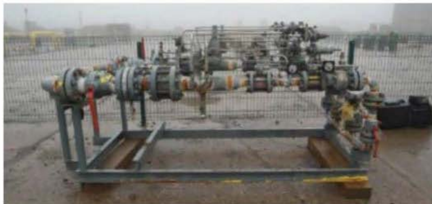
Figure 90: SGN PRI skid.
