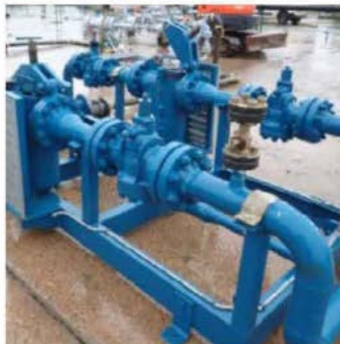
Figure 90: SGN PRI skid.
